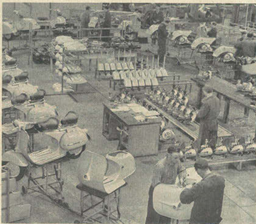
▲ In der großen Halle werden die VESPA's auf langsam weiter wandern- den Tischen — dem Fließband — montiert. Im Vordergrund links, An- fang und Ende des Bandes.
